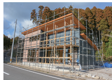
建築中の「音無テラス」
