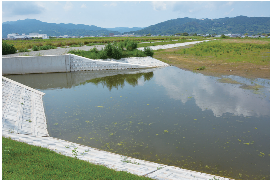
2月に完成した尼寺第2雨水調整池
