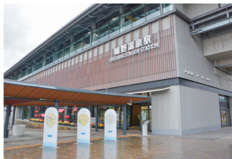
西九州新幹線の嬉野温泉駅。開業から1年が経過し、駅周辺整備も進んでいる
