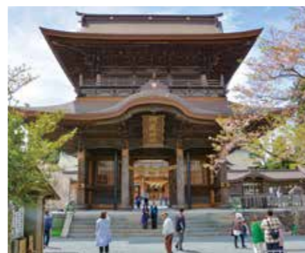
熊本地震で全壊した阿蘇神社の楼門はかつての威容を取り戻していた
